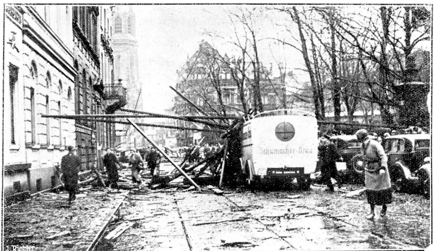
Unwetter hauste im Rheinland.
