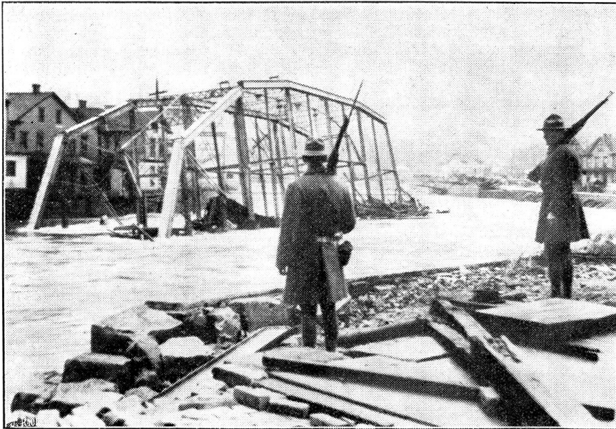
Eine Brücke von der Flut weggeschwemmt.
