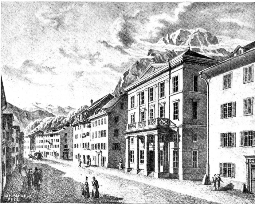
Regierunqsgebäude des Kantons Glarus vor dem Brande.
