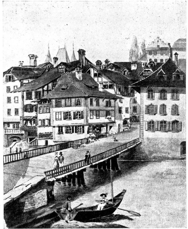
Thun. Die hölzerne Sinnebrücke aus dem Anfang des 19. Jahrhunderts.
