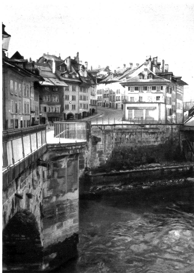
Nydegghbrücke mit Läuferplatz und Stalden
