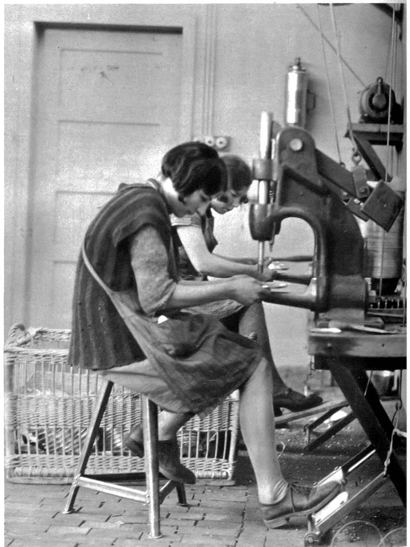
In der Schleiferei. Die egalisierten Hohlgefäße werden auf Spezial-Schleif- maschinen innen fein geschliffen.
