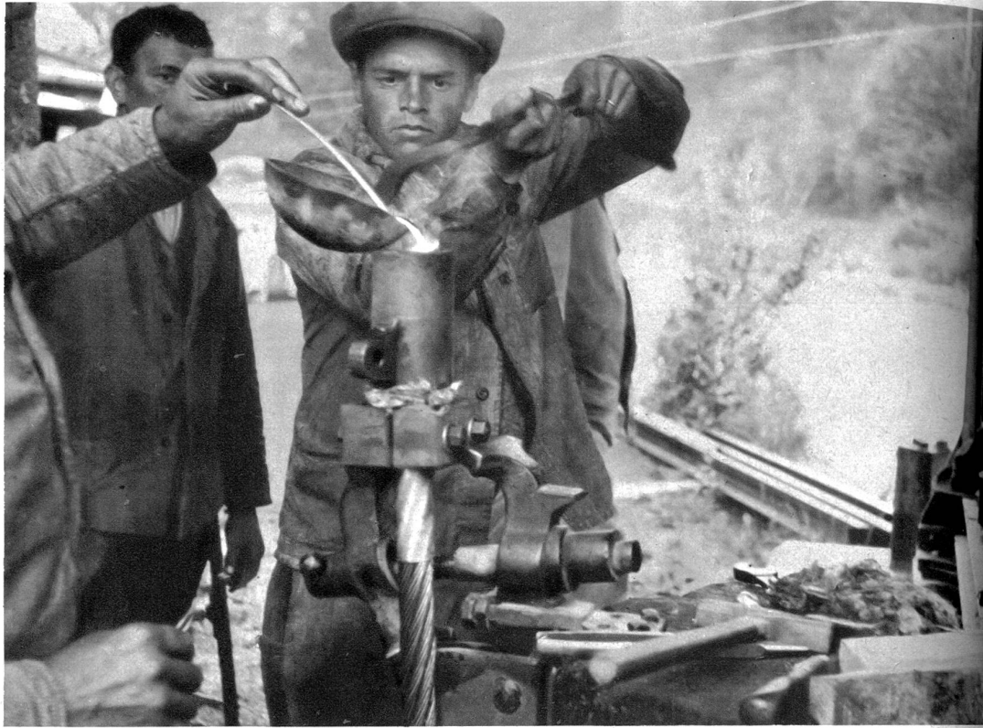
Der Seilkopf wird ausgegossen
