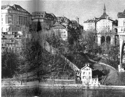
Ansicht des alten Gerbergrabens vor dem Umbau
