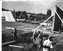
Zimmerleute aus Ostermündigen beim Aufrichten der Stützbalken.
