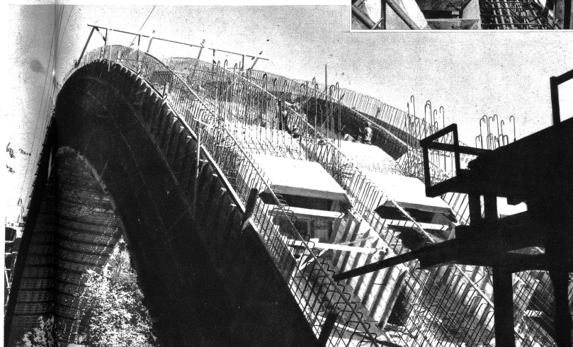
Ein Sektor des Brückenbogens wird mit Kränen eingesetzt
