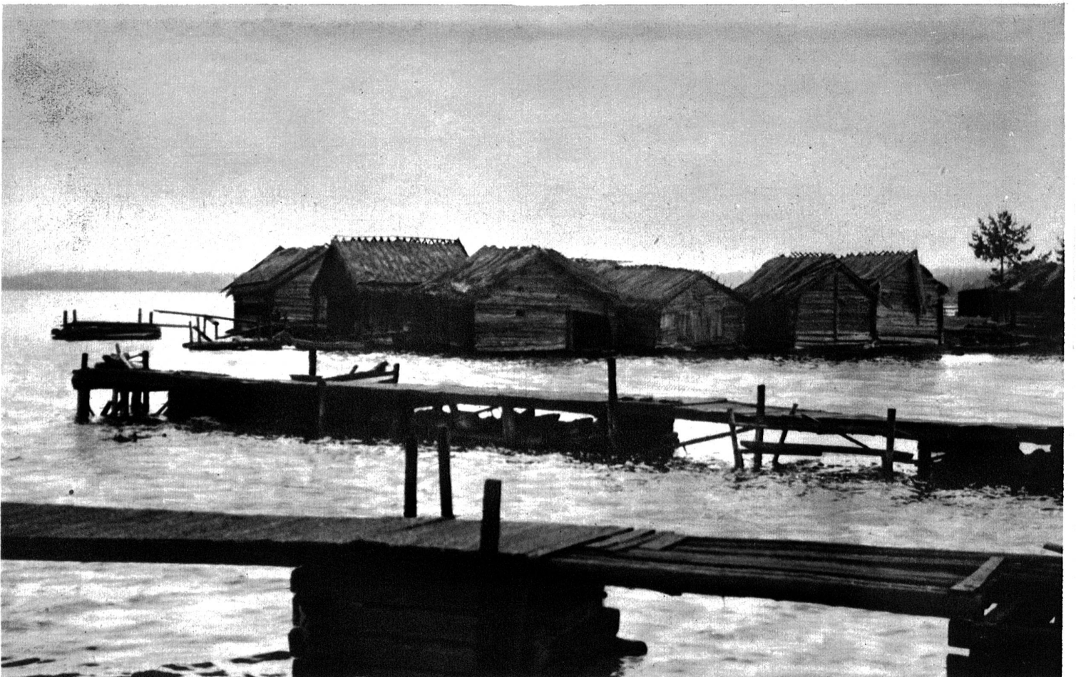
Pfahlbauten in der Fischersiedlung Bonäs im Norden der Inselgruppe. Man fährt mit dem Boot ins Haus hinein, vorsorgt dort die Geräte und die Beute.
