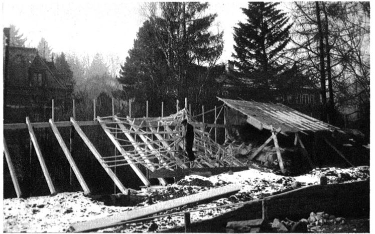
Vater Seiler nagelt soeben eine Latte an den stolzen Gipfelbau der Birre ob Kandersteg. Im Hintergrund sind die Fisistöcke im Rohbau fertig geworden und unter Dach gekommen.
