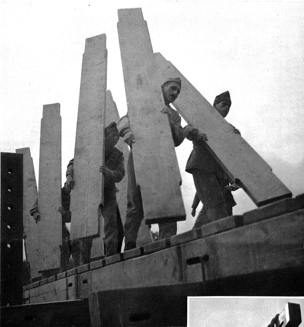
Ein Ladetrupp schreitet mit 20 Läden, die für eine Brückenspannung von 7 m Länge benötigt werden, über den bereits fertig erstellten Teil der Pontonbrücke hinweg.
