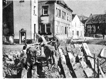
Beseitigung von Strassenspuren.
