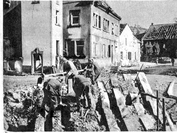
Beseitigung von Strassenspuren.
