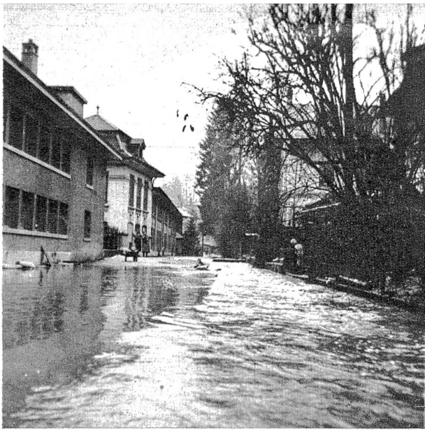
Der sonst so harmlose Sulgenbach hat die Strassen des Brunnmattquartiers in eine Unzahl heimtückischer Bach- und Flussbette verwandelt. (Photo Klameth).
