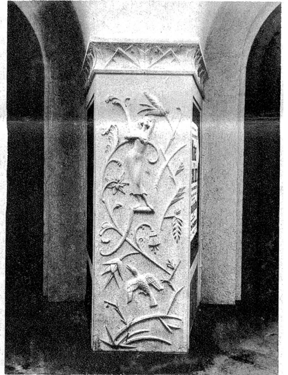
Bauplastik. Pfeilerornament am Kino Splendid
