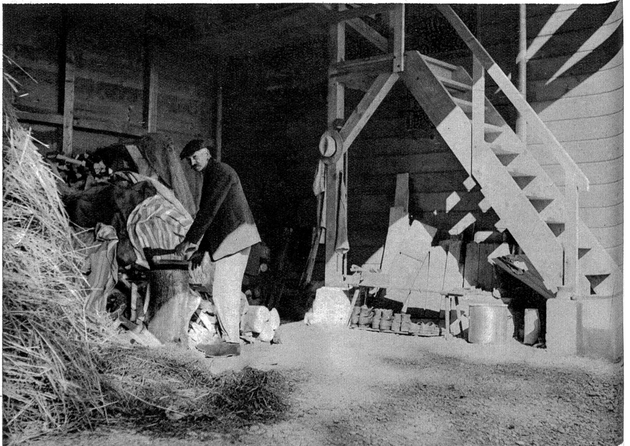
Im Schopf liegt Stroh aufgeschichtet, wird Holz gespalten usw. Die Aussentreppe führt in den Dachraum, der ebenfalls Wohnzwecken oder aber als Lagerraum dient.
