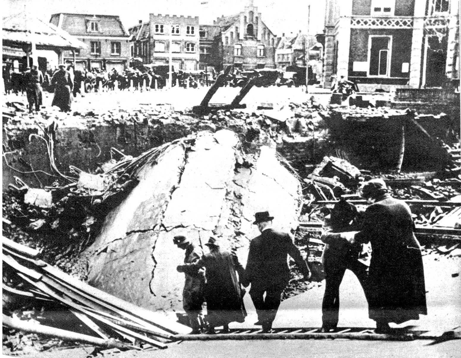
Verheerende Wirkung des Bombardements einer belgischen Stadt. Der Marktplatz ist nurnmehr mit Leitern zu traversieren.
