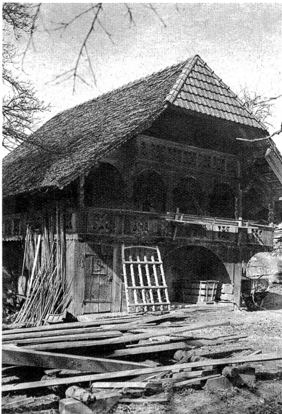
Speicher Lüthi vor der Instandstellung.
