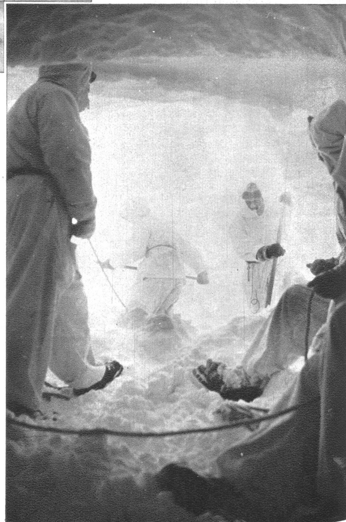
In Stunden harter Arbeit ist ein Eisstollen in den Firn gegraben worden. Die Mannschaft, die den Aushub aus dem Stollen ins Freie befördert, muss angesiebt werden, damit sie vom ständig tobenden Höhensturm nicht in die Tiefe gerissen wird.
