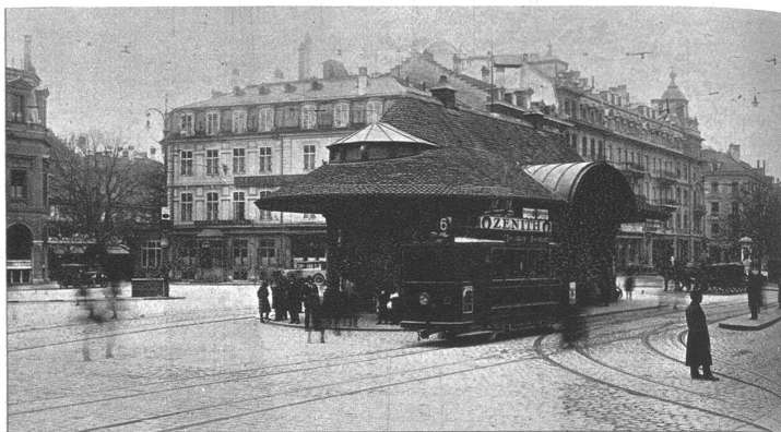
Das 1913 für die Landesausstellung erbaute massive und gemütliche Tramhäuschen Nummer 3, ein ehemals ausserordentlich frequentierter Rendez-vousplatz, und dazu eine beliebte Sitz-, Warte- und Wärmegelegenheit. Es wurde 1930 abgebrochen um für einige Zeit einem Flachdachglasgebäude Platz zu machen, bis sich spätere Zeiten wieder anderen Stilprinzipien als den einzig richtigen zuwenden.
