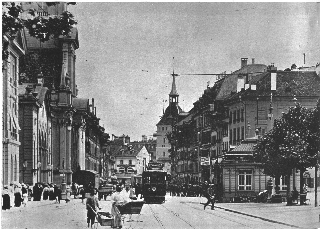
Das Tramhäuschen Nummer 2, das im Jahre 1913 abgebrochen wurde und in der Landesausstellung 1914 eine kurze Auferstehung feierte, allwo es am Rand des Bremgartenvaldes, schmuck und aufgefrischt, als Erholungs- und Ruheraum für weibliche Ausstellungsangestellte diente. Stadtabwärts oben an der Spitalgasse der alte Droschkenhalteplatz.
