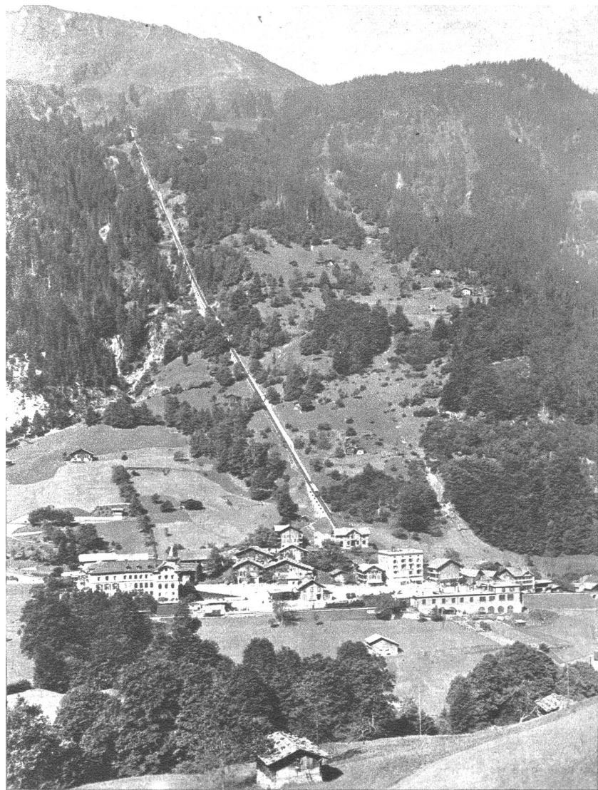
Teilstück Lauterbrunnen-Grütschalp (Photo F. Rohr).
