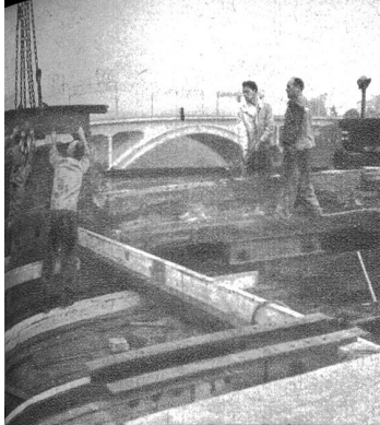
Die alten schweren Eisenträger werden mit Winden und Kranen abmontiert. Im Hintergrund das Symbol der neuen Aera.
