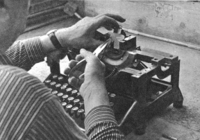
Haarscharf müssen die Typenhebel in die Zentralführung passen. Diese macht 22 Arbeitsvorgänge und 9 Überprüfungen durch und ist hier genau zu sehen
