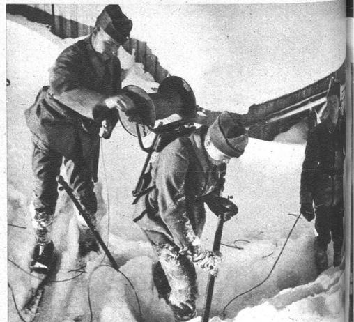
Kein Vergnügen, Leitungsbau im metertiefen Schnee! Das Pack am Rücken wiegt mit der vollen Rolle an die 30 kg
