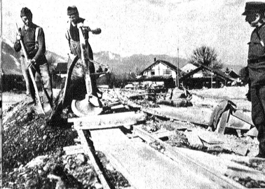
Mit Schubkarren und Rollwagen wird Aushubmaterial zum Aufschütten eines Damms herangeführt
