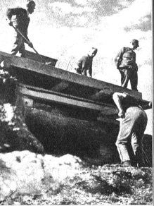
Von morgens bis abends schaffen die arbeitenden Männer Erde, Sand und Stein hinauf zu den Rollwagen, die dann von kräftigen Fäusten über den frisch aufgeschütteten Damm geschoben werden
