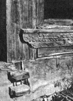
Links: «Althaus»-Einzelheiten. Der ganze mächtige Bau ruht auf gewolligen, verzäpften Eichenschwellen. Laubeläden und Fenstergerüste sind reich geschnitzt — Rechts: Heubühne des Althaus. Konstruktion eines Hochstuhls. Eines der letzten auf Berner Boden.
