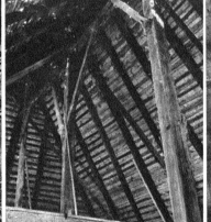
Links: «Althaus»-Einzelheiten. Der ganze mächtige Bau ruht auf gewolligen, verzäpften Eichenschwellen. Laubeläden und Fenstergerüste sind reich geschnitzt — Rechts: Heubühne des Althaus. Konstruktion eines Hochstuhls. Eines der letzten auf Berner Boden.
