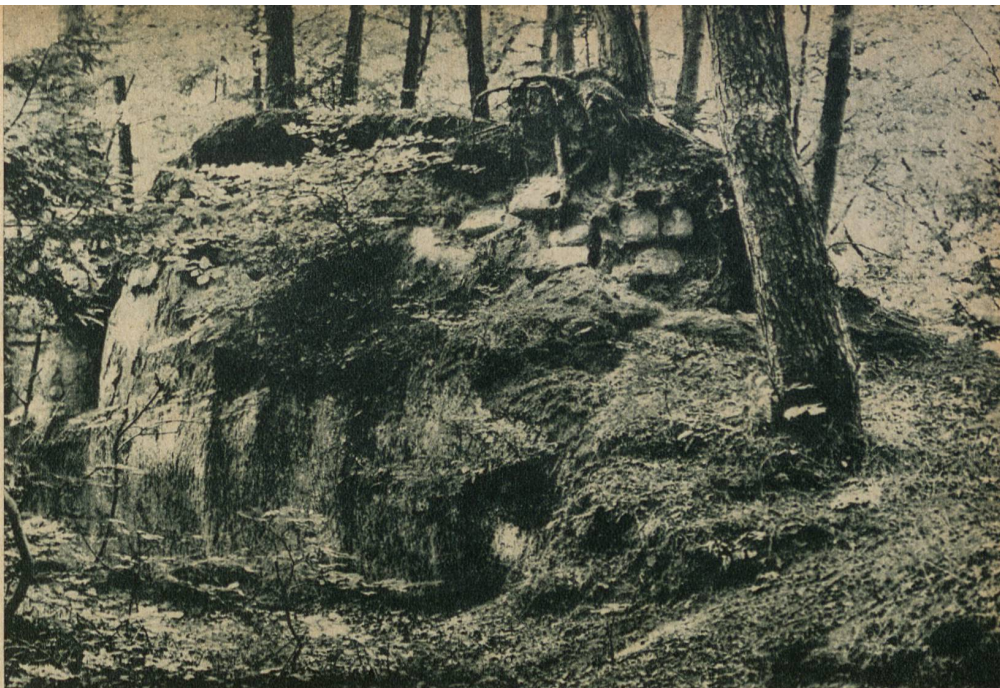
Was von der Schnabelburg bei Melchnau übriggeblieben ist
