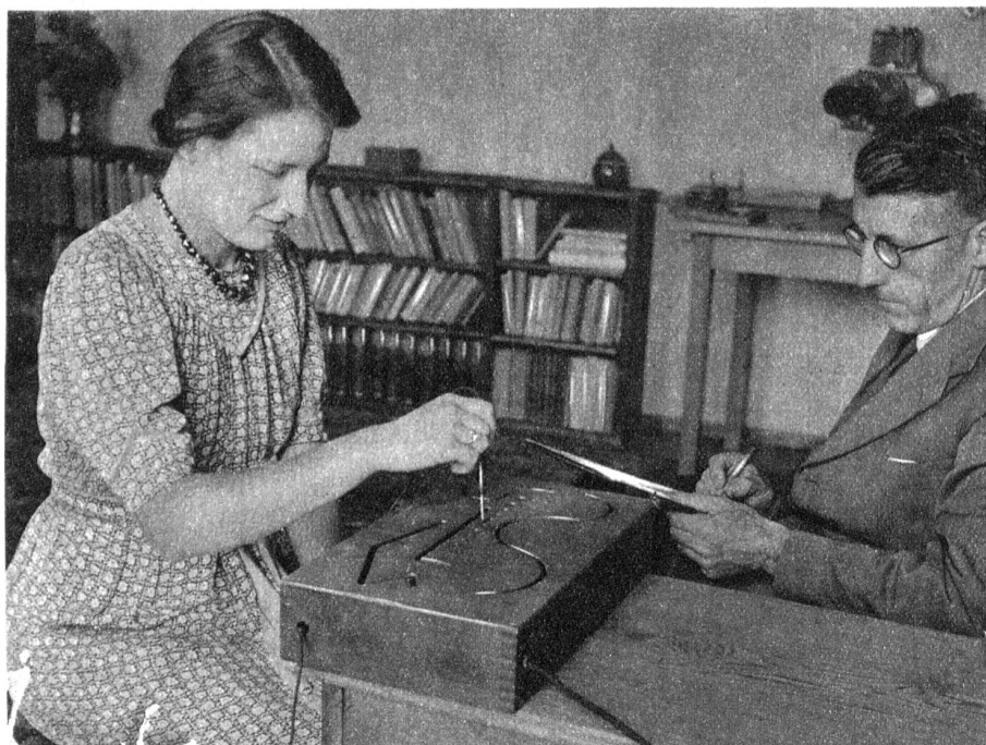
Besonders bei allen mechanischen Berufen spielt die Fertigkeit der Hand eine wesentliche Rolle. Hier wird, ähnlich wie bei einer Drehbank, am Zweihandprüfer die Fertigkeit erprobt
