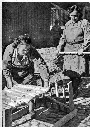
Links: Aus Papier, einigen Schnüren und einem selbstgezimmernten Gestell werden Bettunterlagen gewoben
