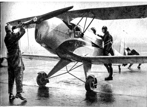
Oben: Technischer Dienst und Erstellen der Flugbereitschaft. Verständlicher als jede noch so gut vorbereitete Theorie ist der Anschauungsunterricht. Der Flugschüler muss den Motor, seinen treuen und zuverlässigen Begleiter, bis in alle Einzelheiten kennen. Die Kenntnisse, welche bereits in Rekruten- und Unteroffizierschule erworben werden, erfahren eine Erweiterung und Vertiefung. — Wie viel eszoller ist nun das Drehen des „Schwirbels“ oder das Schützen an der Kurbel — auch wenn ein anderer zum Fliegen kommt — denn beim nächsten Fluge sitzt man selbst am Steuer und erteilt die nötigen Befehle zur Flugbereitschaft, während man „früher“ buchstäblich nur das Nachsehen hatte!
