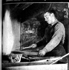
Die «Karotten» der Zahnstange im Kohlenfeuer
