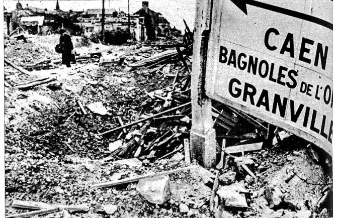
Im Kampfraum von Caen. Der Wegweiser, der als einziger den Bombenhagel einigermaßen intakt überstanden hat, verrät noch die Strassenkreuzung, die sich einmal an der Stelle dieses Bombenkraters befand.
