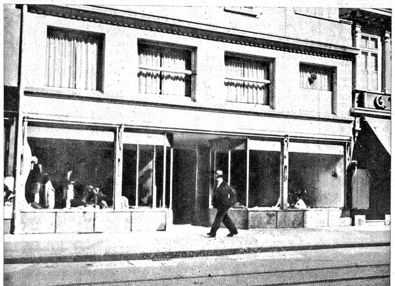
Frontansicht des Geschäftshauses der Firma Löffler & Cie.
