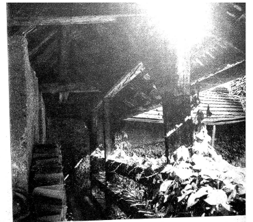
Wehrgang in der Stadtmauer
