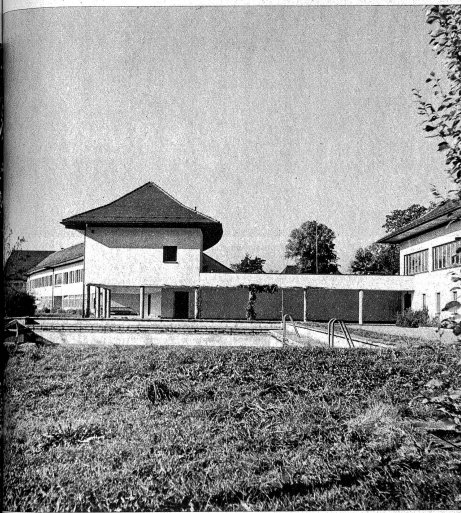
Jugendbau von Osten. Im Vordergrund das Schwimmbassin, im Winter als Eisbahn benutzt wird. Die Zöglinge wohnen in Gruppen von höchstens 15 Kindern. Jede Gruppe wird von Gruppenleiterin betreut. Von schöner Wirkung ist die leichte Krümmung des Zöglingstraktes.
