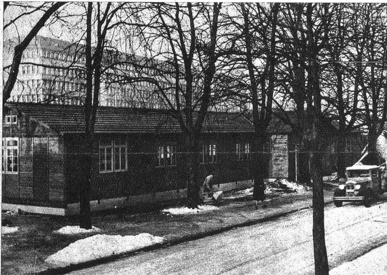
Mitten in Zürich, bei der Sihlpost, ist innert wenigen Tagen eine Barackenbaute entstanden, welche dem Schweiz. Roten Kreuz, Kinderhilfe, sowohl als Administrations- und Verwaltungsgebäude, wie auch als erstes Auffangquartier dient
