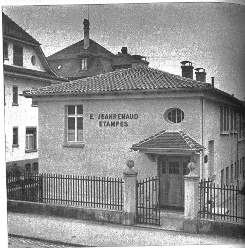
Vue de la fabrique d'étampes E. Jeanrenaud, Bienne Ansicht der Stanzwerkzeugfabrik E. Jeanrenaud, Biel
