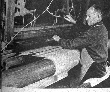
Rechts: Ein ganz hervorragender Handweber wibt auf dem Hand-Jacquardstuhl
