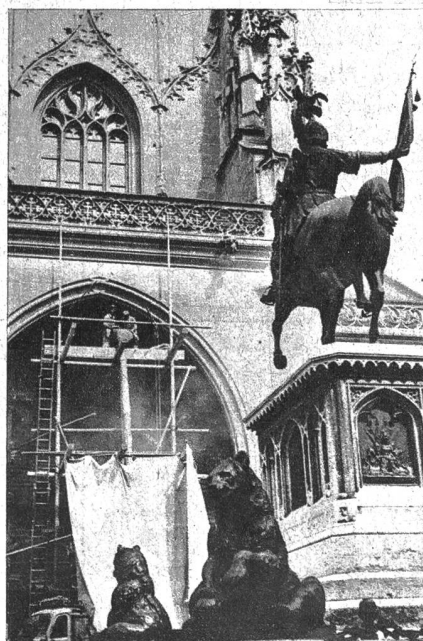
Durch die Einstellung der Feindseligkeiten auf dem europäischen Kontinent können nun die wandhohen Sandsackmauern am Berner Münster, die das prachtvolle Portal schützten, wieder weggenommen werden. (Ph.-P.)
