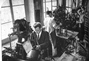
Die Leterschuh-Zwickerei. Hier wird dem Schuh gewisse der Charakter gegeben, denn mit Hilfe dieser Maschinen & Wunder der Technik sind, wird der Schaft über die festsogenannten Leisten an die Brandsohle befestigt
