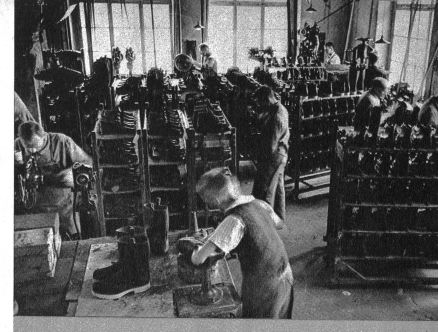
Teilansicht der Bodenabteilung
