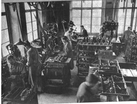
Der Absatzbau. Fleck auf Fleck geschichtet ergibt den Absatz. Dieser wird hier mit ca. 30000 kg Druck in die richtige Form gepresst
