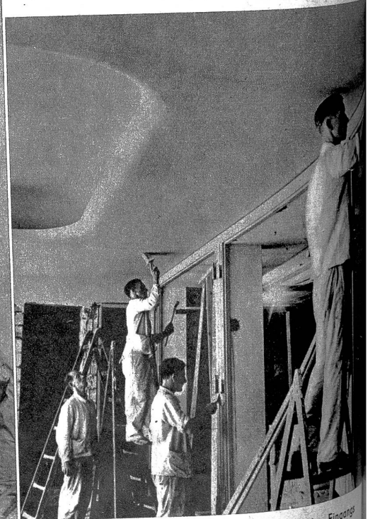
Arbeiten an den grossen Doppeltüren des Eingangs
