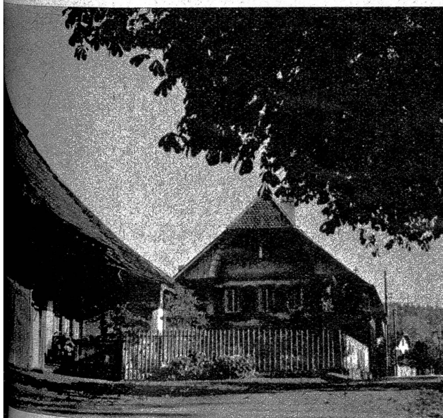
Eine heimelige Dorfpforte in Lyss. Ausser grosszügigen industriellen Anlagen findet sich noch manches schöne Bauernhaus mit seinem Stöckli in der Nähe des Dorfes
