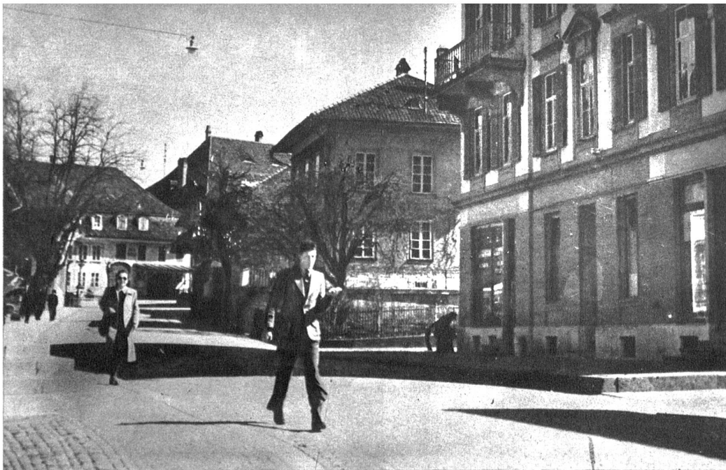
Partie an der Bern-Zürich-Strasse
