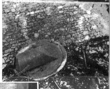
Oben: Die Verschaltung eines Panzerturms, dessen Kuppel durch die Explosion weggeschleudert wurde. — Unten: Kuppelaufbau des Panzerturms, welcher mit dem Geschütz einige Dutzend Meter vom Standort weggeschleudert wurde. (ATP)
