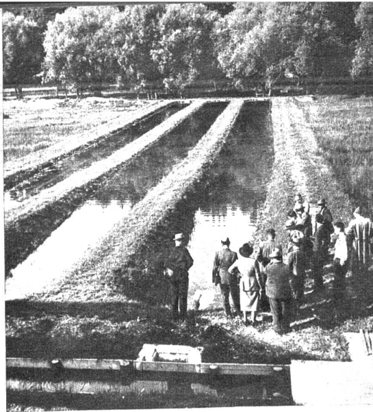
Oben links: Durch eine Pumpstation wird das Aarewasser zuerst in einen Ausgleichsteich gelassen, um den Druck des Wassers abzuschwächen. - Unser Bild zeigt den Ausgleichsteich mit dem Verteilerkanal
