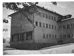
Vor wenigen Jahren wurde in Schwarzenburg ein modernes Krankenhaus errichtet, das dem ganzen Amt zum Segen gereicht
