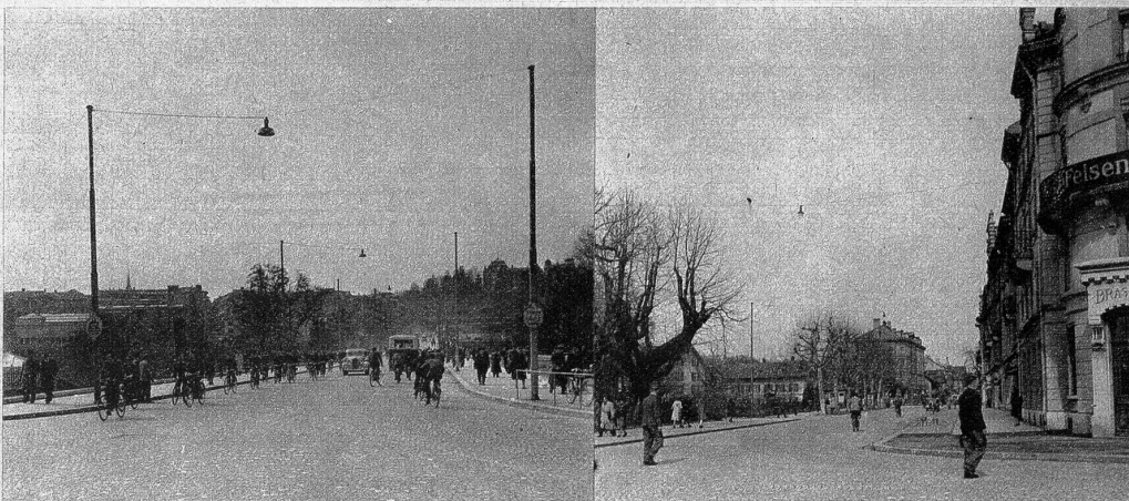
Blick auf die Lorrainebrücke
