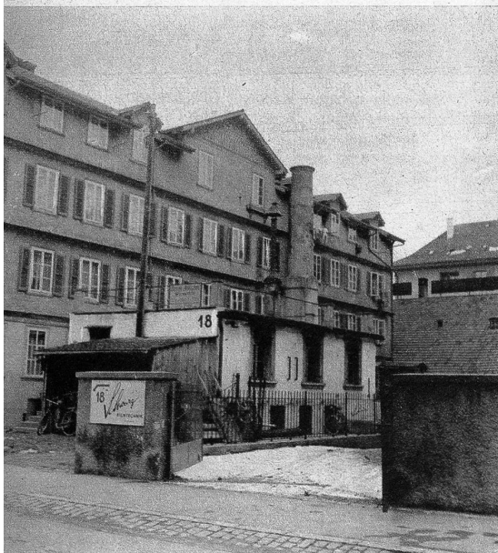
Das einstige Lorraine-Hallenbad mit dem heute noch bestehenden Hochkamin. Dieses wurde seither zu einem Wohnhaus mit zahlreichen Wohnungen umgebaut
