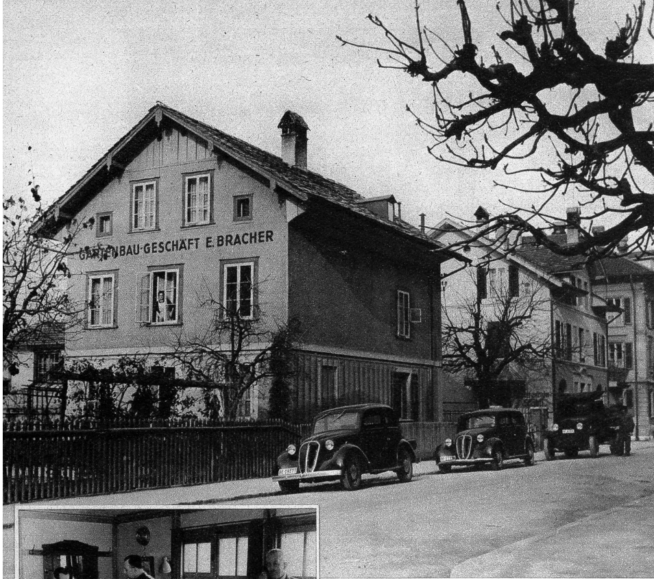
Ansicht des Geschäftshauses
